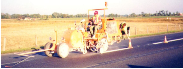
Hosszirányú burkolatjelek festése
